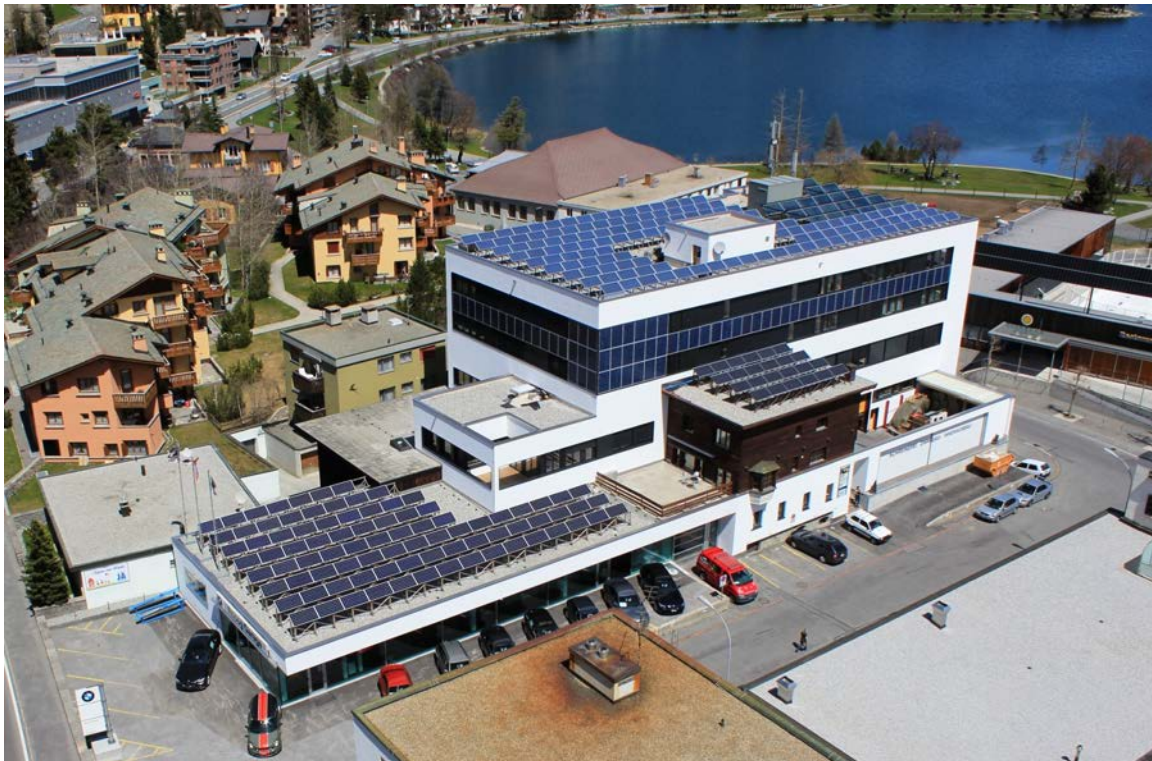
Abbildung 9-6: Malloth AG, Sankt Moritz. Installationsjahr 2010 und 2011. Anstellwinkel 30, 35 und 90 Grad; Himmelsrichtung Süd-Ost und Süd-West. Installierte Leistung 63,68 Kilowatt-peak; 73 Megawattstunden/Jahr (2013)
