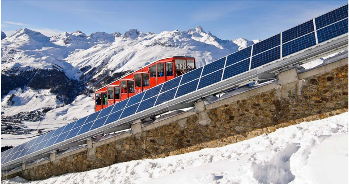
Abbildung 9-9: Muottas Muragl, Samedan. Anstellwinkel 49 Grad. Himmelsrichtung 15 Grad Abweichung von Süd in Richtung Ost. Installierte Leistung 64 Kilowatt-peak. Stromertrag 101 ( \pm 5) Megawattstunden/Jahr
