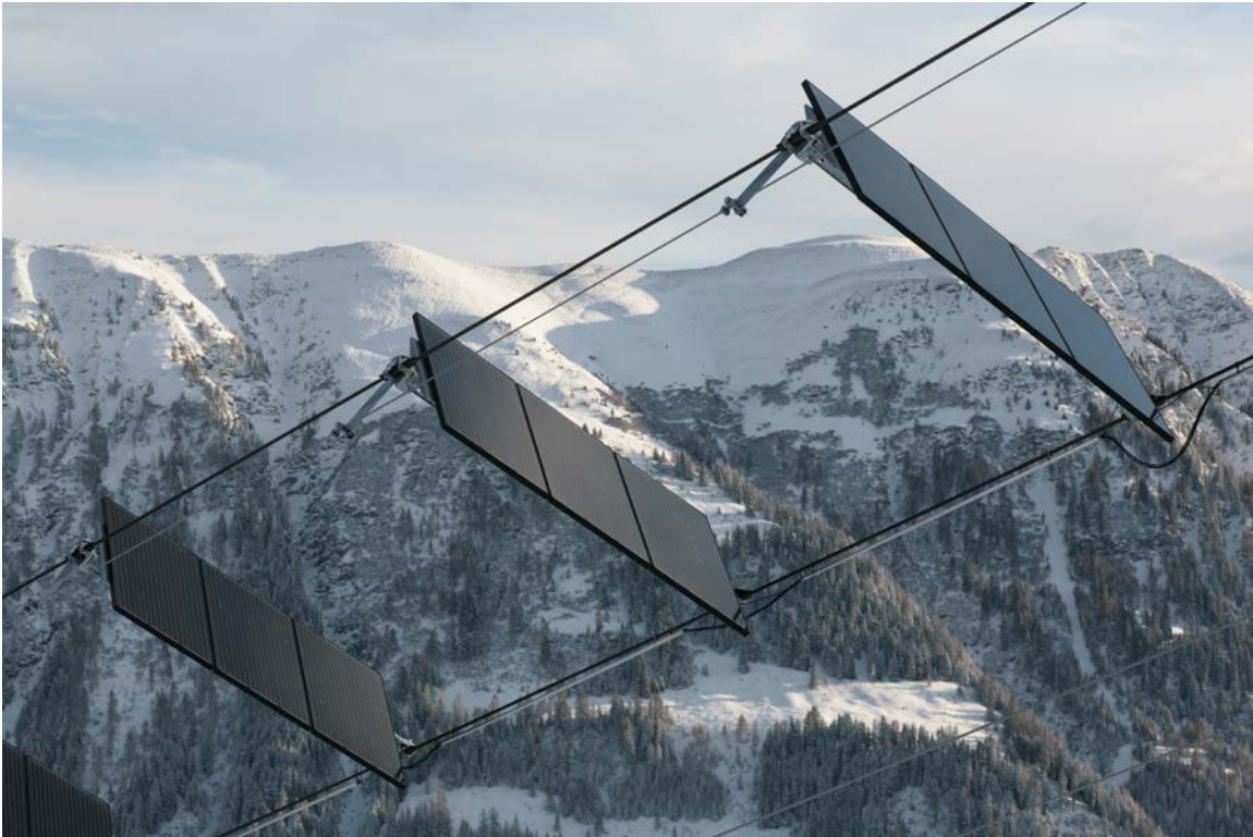
Abbildung 3-3: Solarskilift Tenna. Länge Modulfeld 330 Meter. 60.3 Kilowatt-peak. 90 Megawattstunden/Jahr
