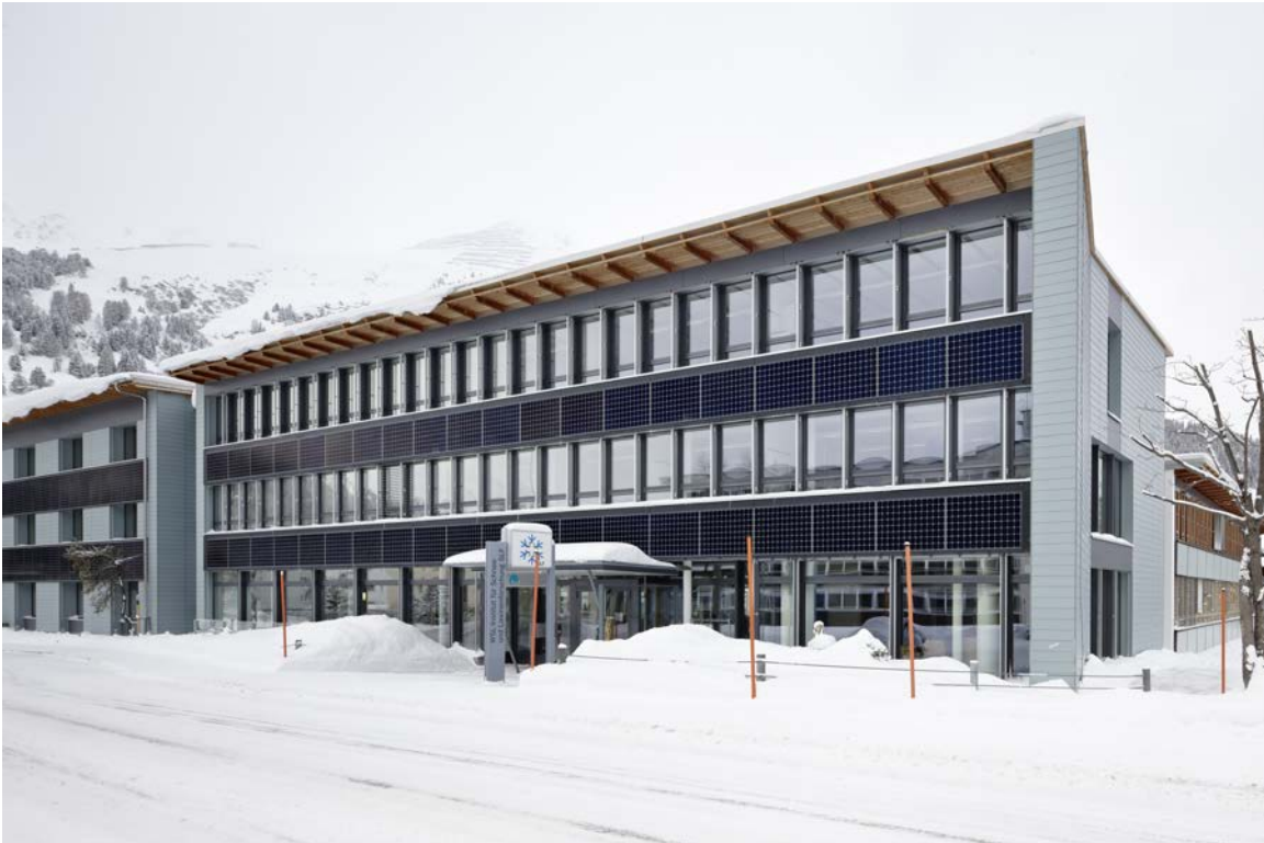
Abbildung 9-3: Institutsgebäude WSL-Institut für Schnee- und Lawinenforschung in Davos, fassadenintegrierte Anlage. 76 monokristalline Silizium-Module zu je 315 Watt-peak (gesamt 23.94 Kilowatt-peak), Ertrag circa 21 Megawattstunden pro Jahr
