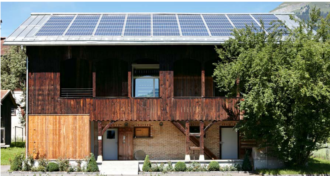
Abbildung 9-4: Stall zu Büro in Grüşch. Schweizer Solarpreis 2009. Installierte Leistung 22,05 Kilowatt-peak; 161 m 2 Module; Ertrag 19 Megawattstunden/Jahr
