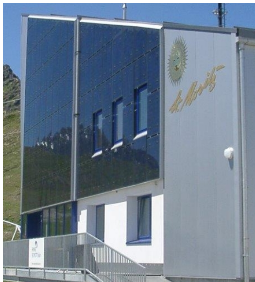
Abbildung 9-8: Sankt Moritz. Piz Nair Talstation (links) installierte Leistung 9,7 Kilowatt-peak. Berg-Station (rechts) Fassade installierte Leistung 13,5 Kilowatt-peak; Modulfläche 130 m 2 ; 104 Module mit Lochbefestigung, hohe Windbelastung
