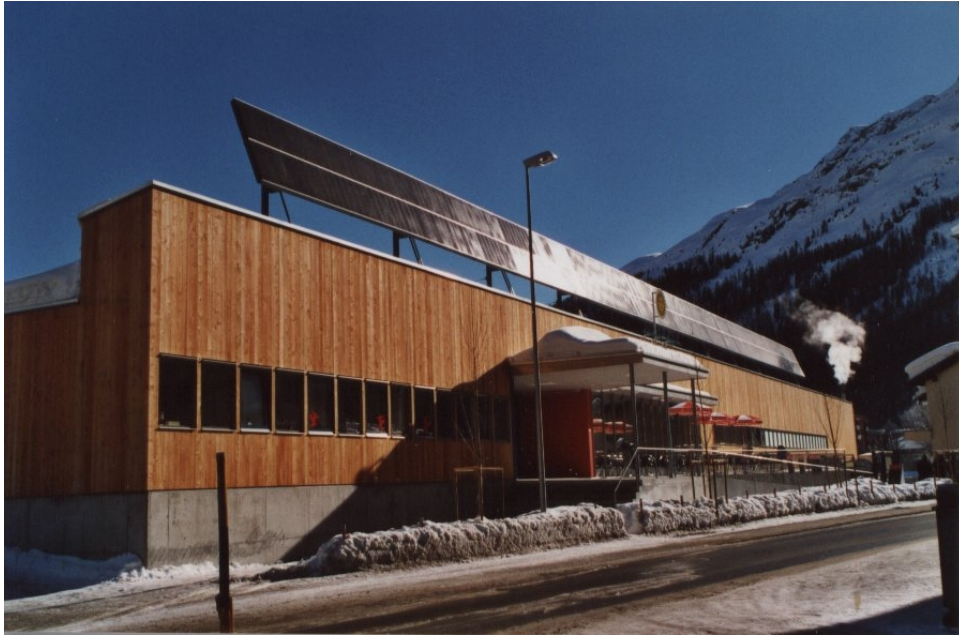
Abbildung 9-5: Eisstadion Sankt Moritz, Dünnschichtmodule Kupfer-Indium-Selenid. Installierte Leistung 17 Kilowatt-peak; 410 Module
