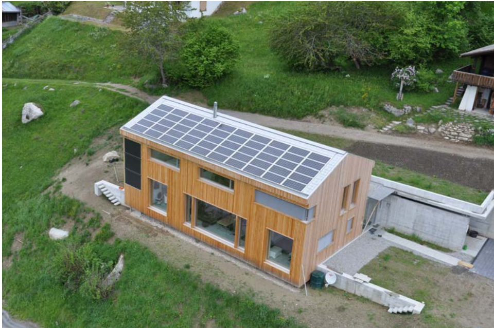
Abbildung 9-1: Wohnhaus, Plusenergiebau, Ruschein. Installierte Leistung 6,6 Kilowatt-peak; Dachfläche 132 m 2 ; Neigung 22 Grad; Modulfeld 50 m 2 ; 7,7 Megawattstunden/Jahr. Schweizer Solarpreis 2010
