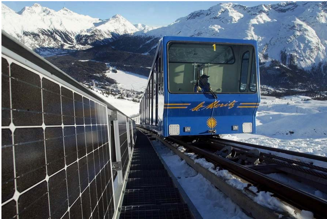
Abbildung 9-10: Bergbahn-Geländer, Corviglia-Standseilbahn Sankt Moritz. Installierte Leistung 17,82 Kilowatt-peak; Modulfläche 139 m 2
