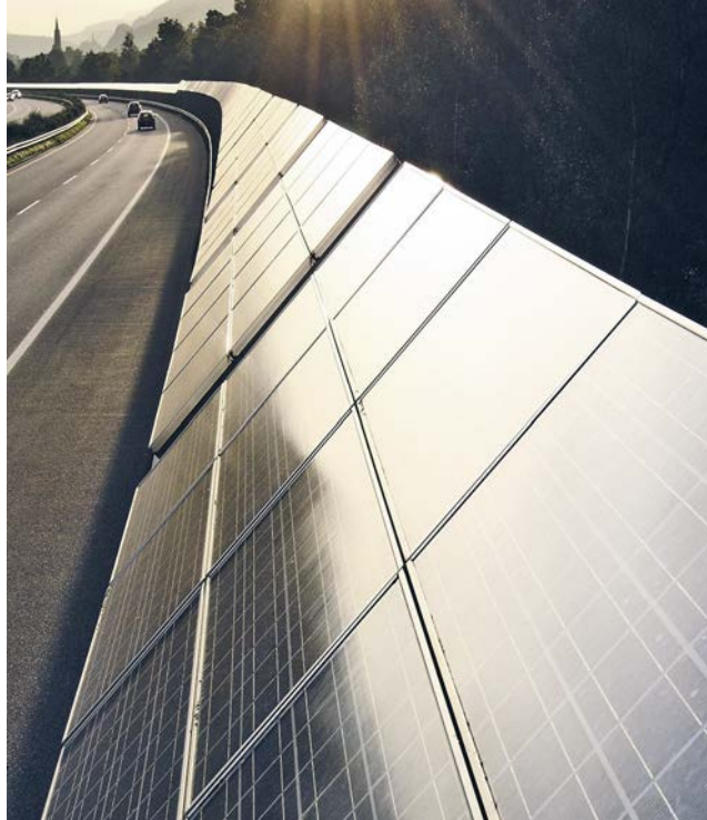
Abbildung 3-2: Schallschutzwand Autobahn A 13, Domat/Ems-Felsberg, Länge 828 Meter, Modulfläche 994 Quadratmeter, Leistung 110 Kilowatt-peak, Jahresertrag 120 Megawattstunden, Erstinbetriebnahme 1989, Sanierung 2005
