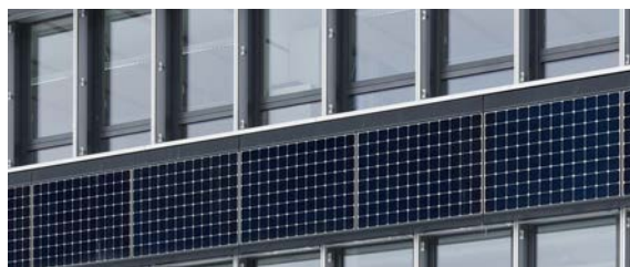
Abbildung 2-1: Davos Dorf Bürogebäude WSL-Institut für Schnee- und Lawinenforschung. Fassade 76 monokristalline Silizium-Module zu je 315 Watt-peak (gesamt 23.94 Kilowatt-peak), Ertrag circa 21 Megawattstunden pro Jahr
