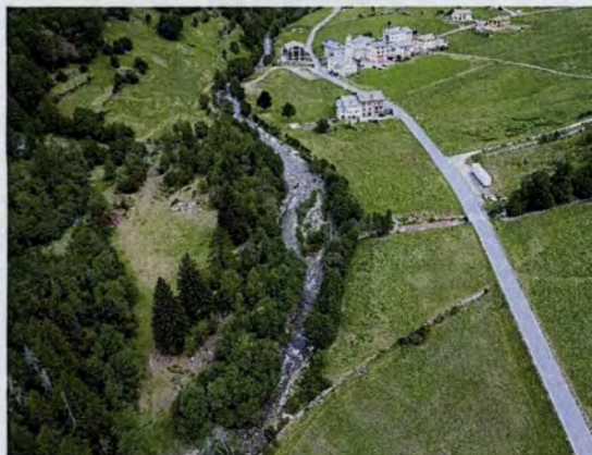
Aktueller Zustand bei Angeli Custodi
