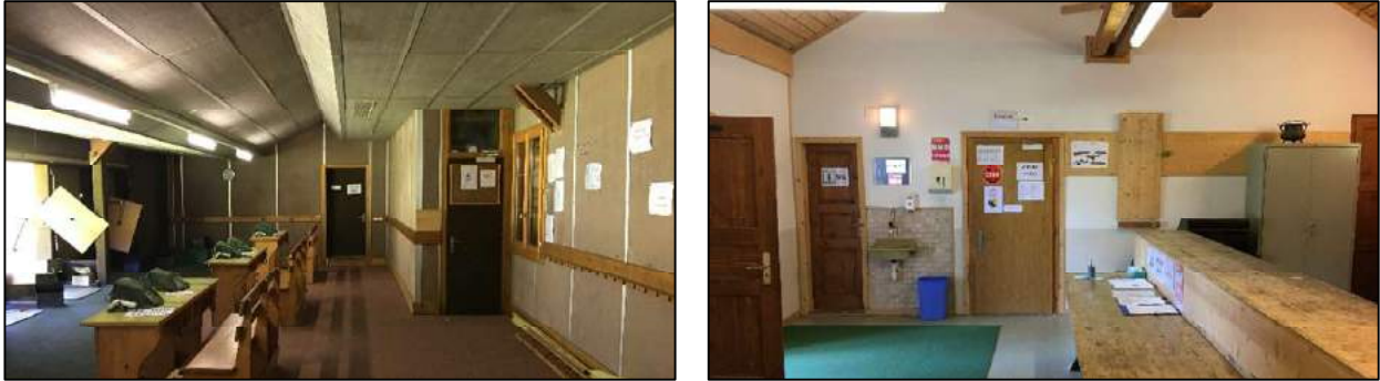
Abbildung 6: Schützenstand 300m-SA, Schiesshalle (links) und Eingangsschleuse (rechts)
