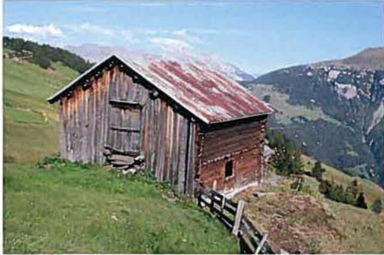
Einfache Stall-Scheune Blockbau aus gestrickten Kanthölzern Auf Wetterseite vertikale Bretterver- schalung
