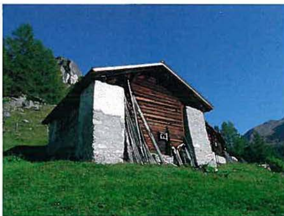
Stall-Scheune (Pfeilerstall) Blockbau aus gestrickten Kanthölzern Gemauerte Pfeiler
