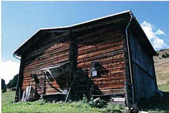
Stall-Scheune mit Anbau Blockbau aus gestrickten Kanthölzern Auf Wetterseite vertikale Bretterver- schalung
