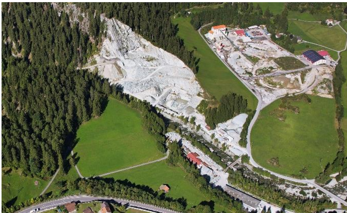
Abb. 2: Steinbruch Cuolmet, Andeer sowie Kies- und Betonwerk Andeer (September 2018; © Comet Photoshopping GmbH / Dieter Enz).
