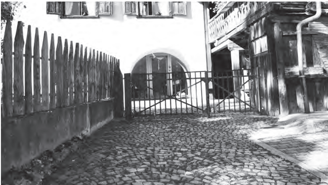
Ill. 104: accesso pavimentato in ciottoli di fiume utilizzabile quale posteggio temporaneo (ad es. Flims).
