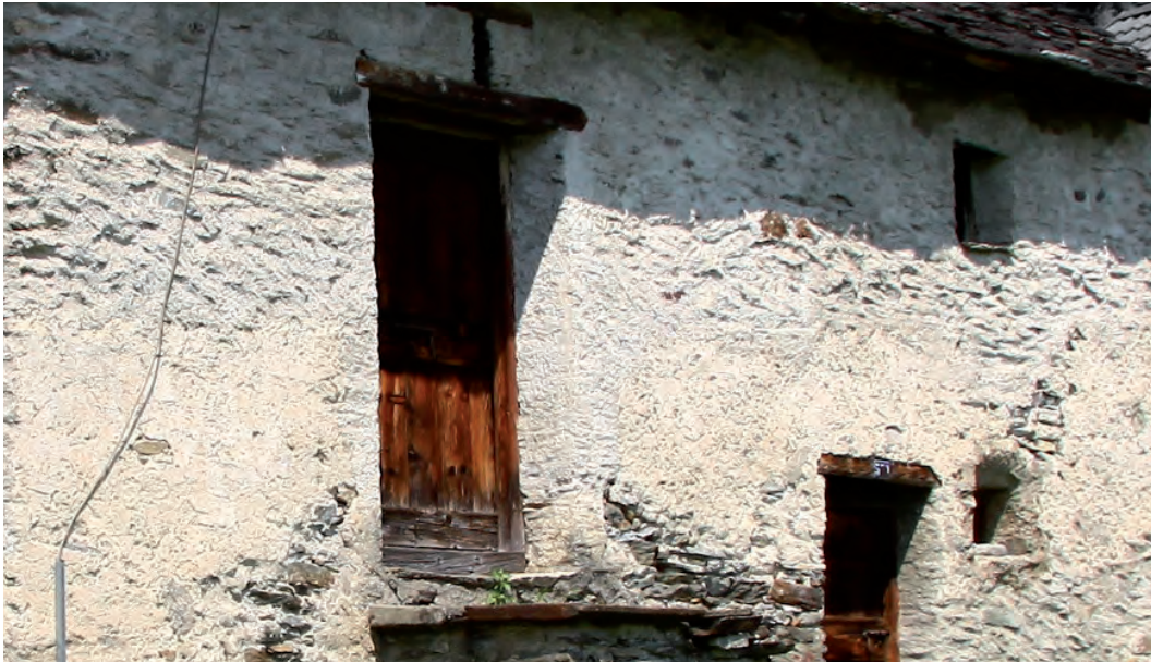
Ill. 63: portoni e finestre nella stalla con fienile in muratura a Mesocco-Cebbia.
