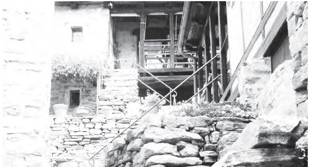
III. 69: terrazze su pianerottolo intermedio e balconi dietro corridoi e rascane, nel nucleo storico di Avegno.
