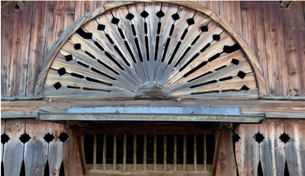
Ill. 37: portone di un fienile, finestra e fessure di ventilazione di forma ornamentale (Flims).
