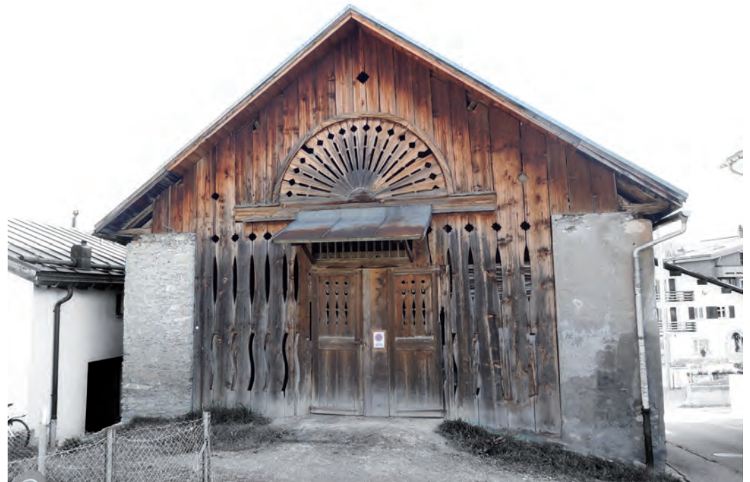
III. 30: stalla con fienile con pilastri angolari con rivestimento ornamentale (Flims).
