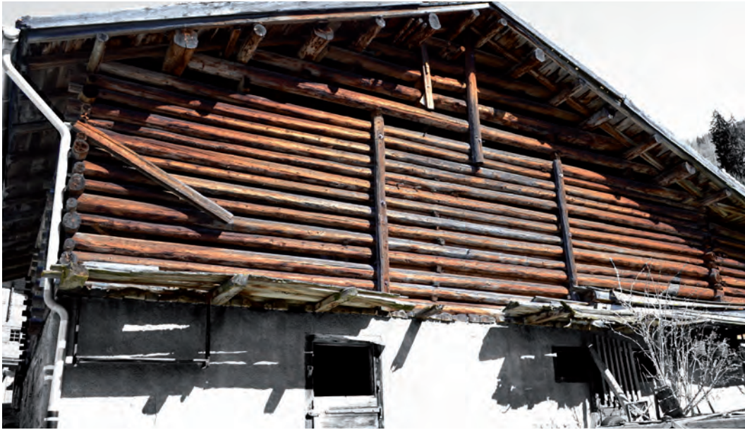
Illustraziun 15: Construcziun da laina radunda sin in uigl da mir (Curaglia).
