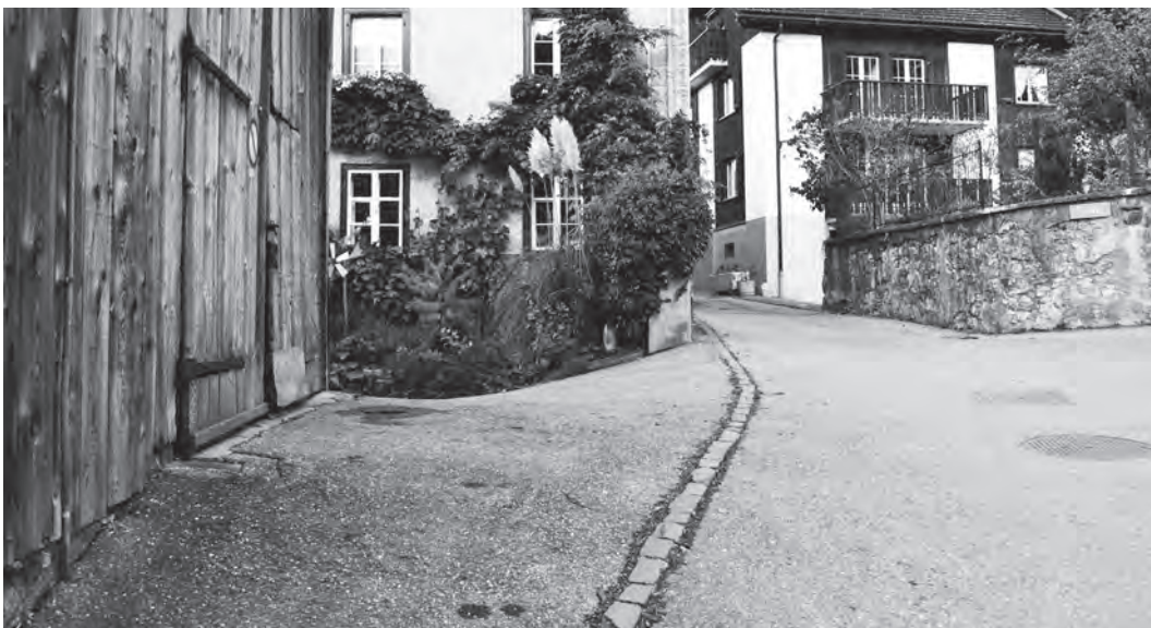
Illustraziun 105: Surfatscha cun cuvrida dira tranter la via e la porta-clavà duvrabla sco piazza da parcar temporara (p.ex. Jenins).
