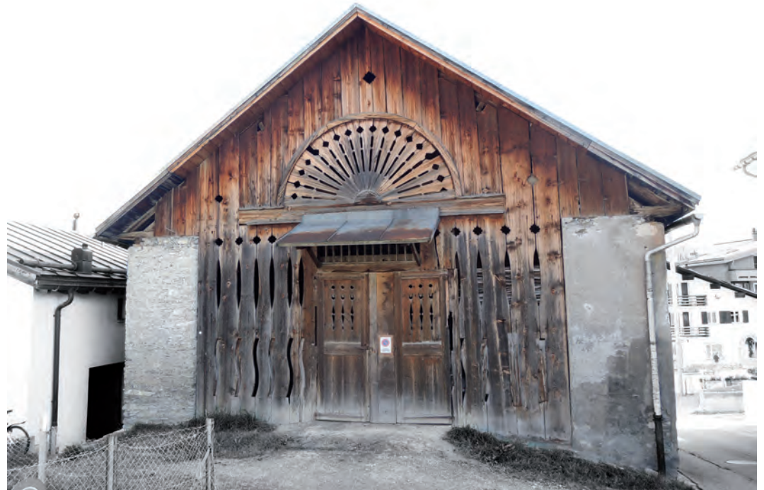
Illustraziun 30: Stalla-clavà a pitgas cun in revestgiment ornamental (Flem).
