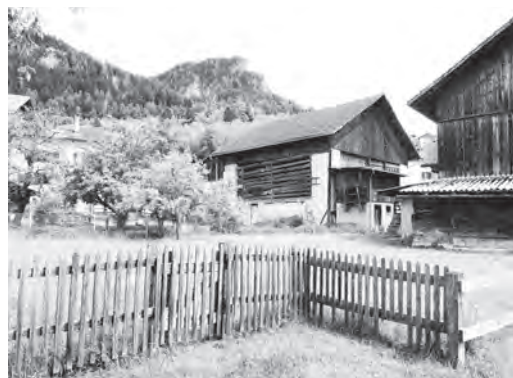
Illustraziun 81: Saiv da lattas verticalas a l'ur da la via (p.ex. Scharàns).
