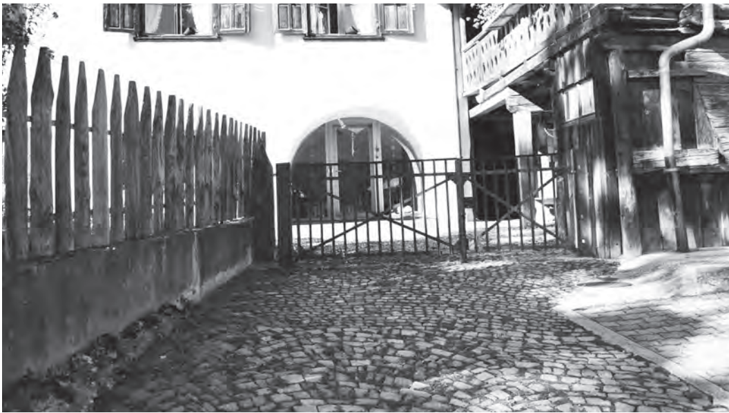
Illustraziun 104: Entrada cun salaschada da crappa da flum, duvrabla sco piazza da parcar temporara (p.ex. Flem).
