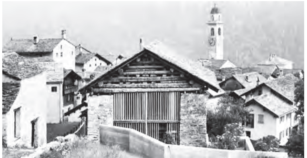
Illustraziun 52: Revestgiment cun aissas moviblas.
