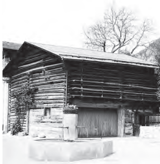
Illustraziun 96: Balcun cuvri sin il chischner da la vart dal stanschain (p.ex. Scharàns).
