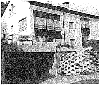
Non è tanto facile costruire in montagna. A causa della vista cui non si vuol rinunciare, ci si avventura nei pendii ripidi, dovendo poi ricorrere a dei puntellamenti in calcestruzzo, ad autorimesse ed opere murarie estranee alle strutture locali. Questi elementi mal si conciliano con il quadro locale e quello del paesaggio.
