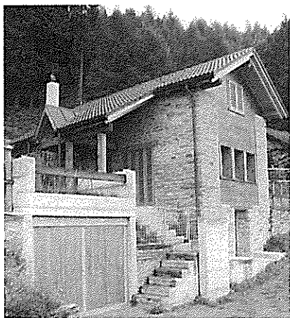
Zweierlei Umnutzungen: Während der zu einem Wohnhaus umgebaute Stall in Ilanz (Bild oben) als angemessene Lösung erscheint, sind die einstigen Strukturen beim unteren Umnutzungsbeispiel weitgehend verschwunden und wirken sie höchstens als nostalgische Erinnerung nach.
