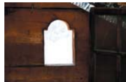
Fenster im Westen
