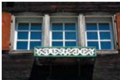
Fenster Fassade Süd
