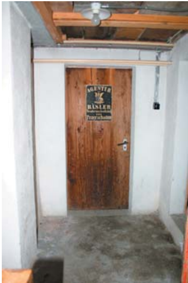
Tür zur Waschküche
