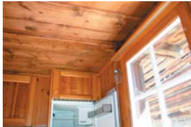
Küche Detail auskragender Balken
