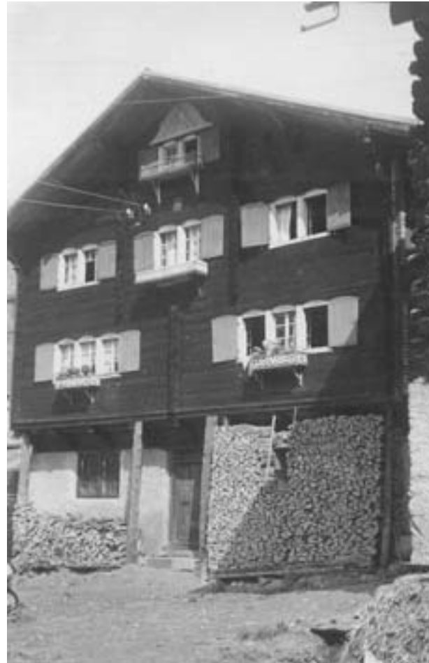
Fassade Süd 1952, ursprüngliche Türe im Keller
