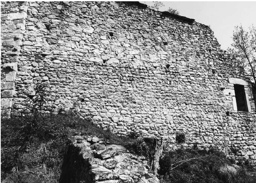
Abb. 67: Die ältere Umfassungsmauer zwischen Kirche und Bergfried, darüber Aufhöhung in der Wiederaufbauphase (horizontale Baunaht).
