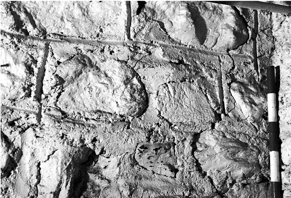
Abb. 36: Der «pietra-rasa»- Verputz mit Fugenstrich zeichnet eine Quaderimi- tation auf die Innenwände.
