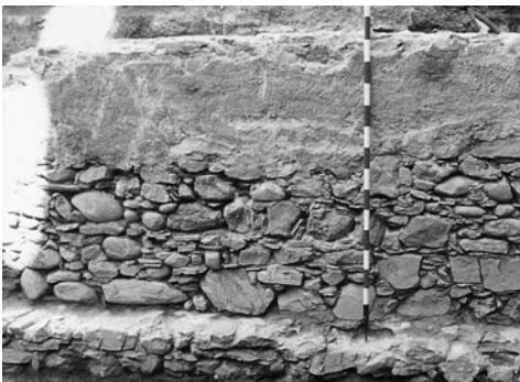
Abb. 20: Chur 1997, Postplatz; Stadtmauer 16. Jh. Ansicht von Süden.
