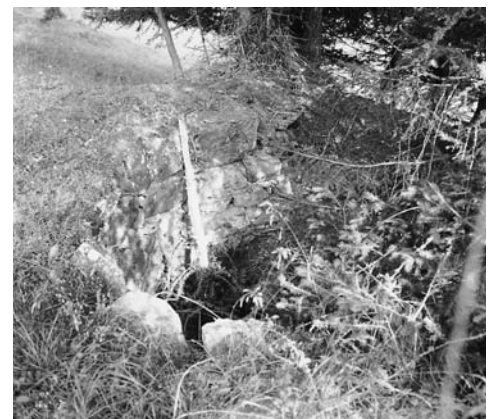
Abb. 60: Stierva 1997, Bargung : Blick auf die erhaltenen Mauerreste des Kalkbrennofens.
