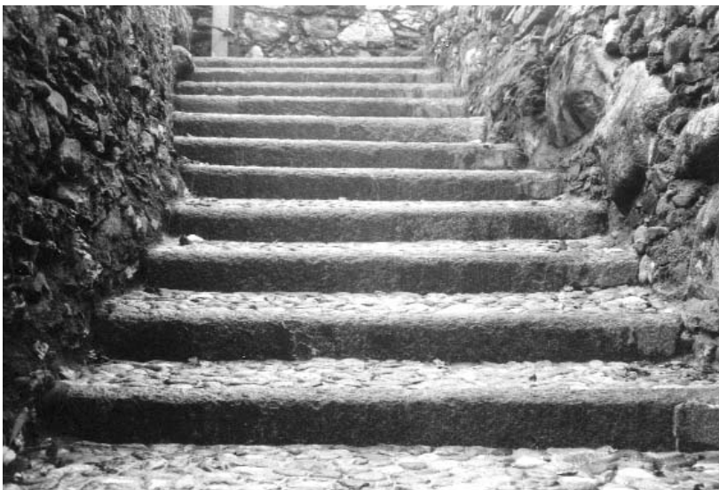
Abb. 98: Roveredo - Toveda, Treppenstufen mit Bollenpflästerung.
