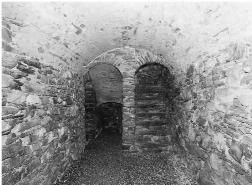
Abb. 97: Chur - Masans, Waisenhaus. Korridor im Untergeschoss mit stichbogigem Tonnengewölbe.
