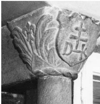
Abb. 73: Chur 1998/99, Reichsgasse 48. Fenster-säule aus Scalärastein.
