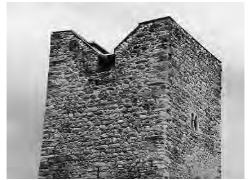
Abb. 144: Waltensburg, Burgruine Jörgenberg. Wohnturm mit neuem Schutzdach, Ansicht von Südwesten.
