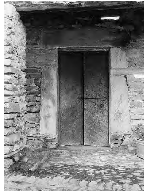
Abb. 154: Castaneda, Haus Nr. 33. Tür im EG mit mittelalterlichem Steingewände.
