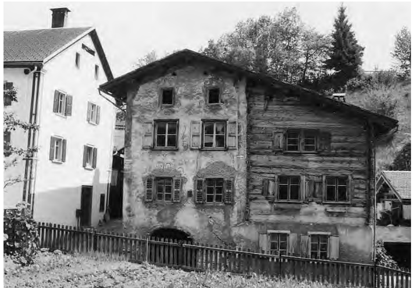
Abb. 149: Trin, Haus Nr. 34. Nordfassade, Vorzustand.
