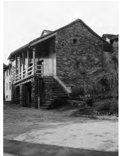
Abb. 153: Castaneda, Haus Nr. 33. Ansicht von Südosten.
