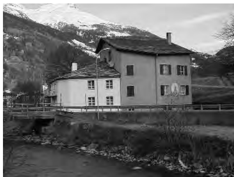
Abb. 105: Poschiavo-Li Curt, Haus Nr. 661. Umbau der Stallscheune in Wohnraum.
