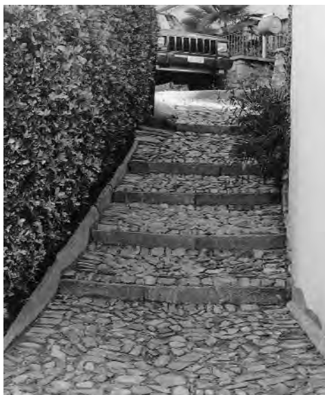
Abb. 107: Instandgestellte Schropfenpflasterung in Castaneda.
