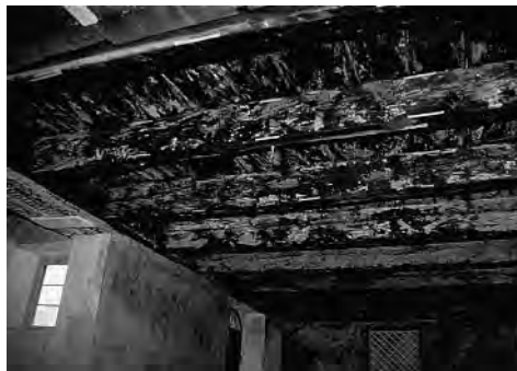
Abb. 54: Müstair, Kloster St. Johann. Heiligkreuzkapelle, Decke über dem Erdgeschoss gegen Westen: Die originalen Balken im Vordergrund wurden 785-788 gefällt, die Balken im erneuerten westlichen Teil 1021/22.
