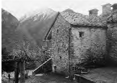
Abb. 152: Castaneda, Haus Nr. 33. Ansicht von Norden.
