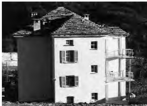
Abb. 104: Die "Casa a Marca" in Leggia nach der Aussenrestaurierung. Rechts vom Treppenhausrisalit die neuen Balkone.
