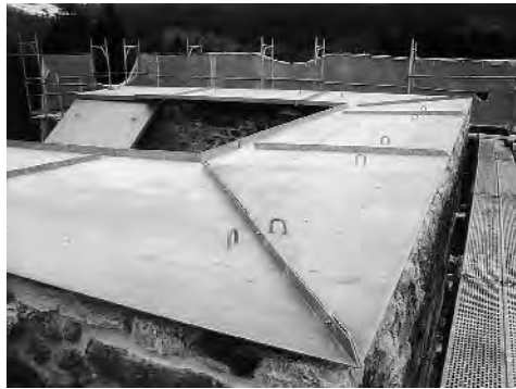
Abb. 143: Waltensburg, Burgruine Jörgenberg. Das aus Blechtafeln bestehende neue Schutzdach über dem Wohnturm.
