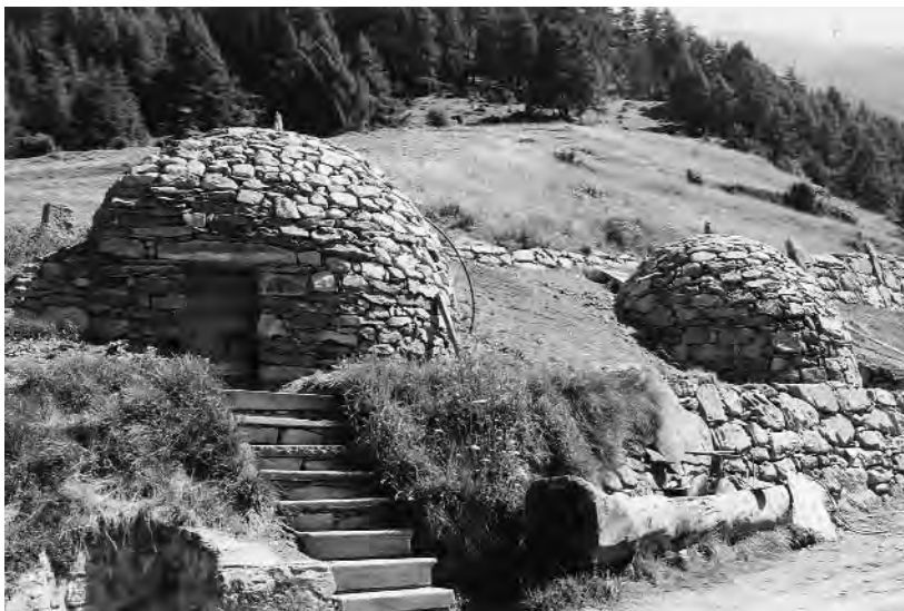
Abb. 103: Brusio-Viano. Instandgesetzte Milchkeller ("Cròt") bei Isola.
