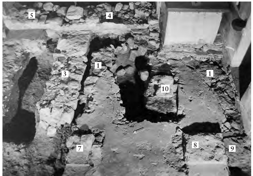
Abb. 59: Schlans, Kirche St. Georg. 3. Situation, SE-Ecke. Nummerierung der Mauern vgl. Abb. 58. Blick nach Osten.
