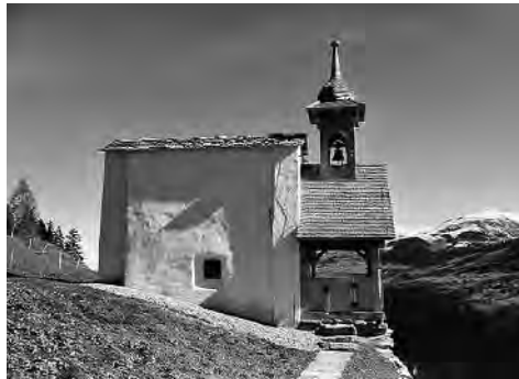
Abb. 115: Dardin-Pugaus, Kapelle St. Nikolaus (Sontga Clau). Südwestseite nach der Restaurierung mit neuem Steinplattendach auf Chor und Schiff und Schindeldach auf Vorzeichen und Dachreiter.
