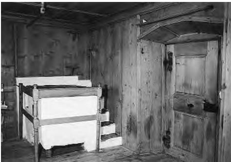
Abb. 161: Trin, Haus Nr. 7. Restaurierter gemauerter Ofen von 1769 in der Erdgeschossstube.
