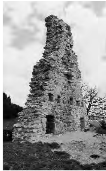
Abb. 127: Siat, Burg Friberg. Der erhaltene Mauerzahn nach der Sicherung. Ansicht von Südwesten.
