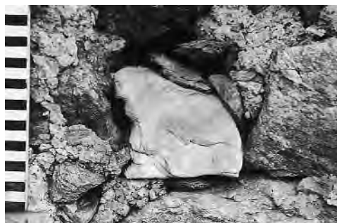
Abb. 132: Siat, Burg Friberg. Ein Gerüsthebel aus der Entstehungszeit der Anlage ergab ein Fälldatum im Jahr 1207.
