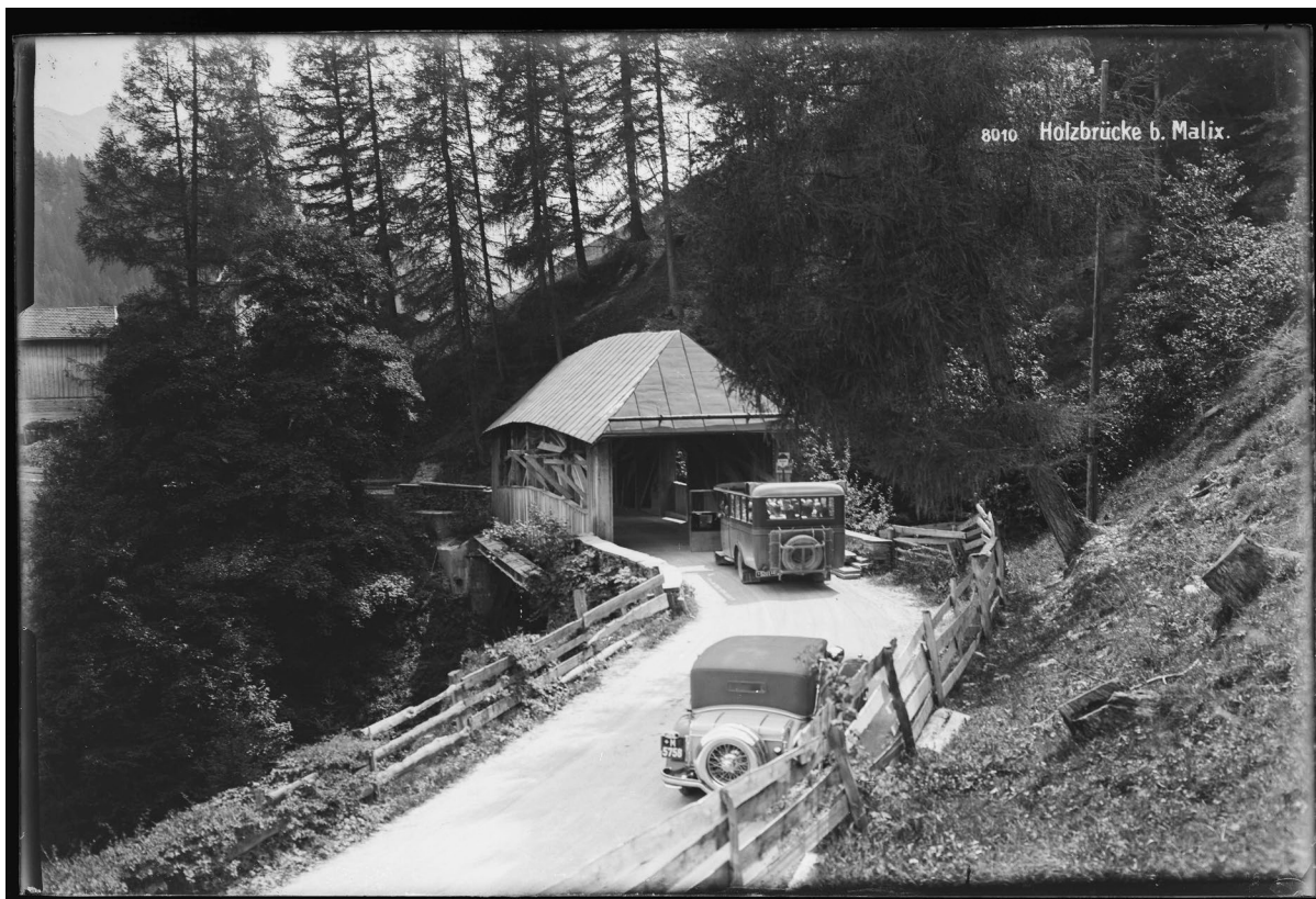
StAGR N3.197: Malix, Holzbrücke mit Bus und Personenwagen 1932
