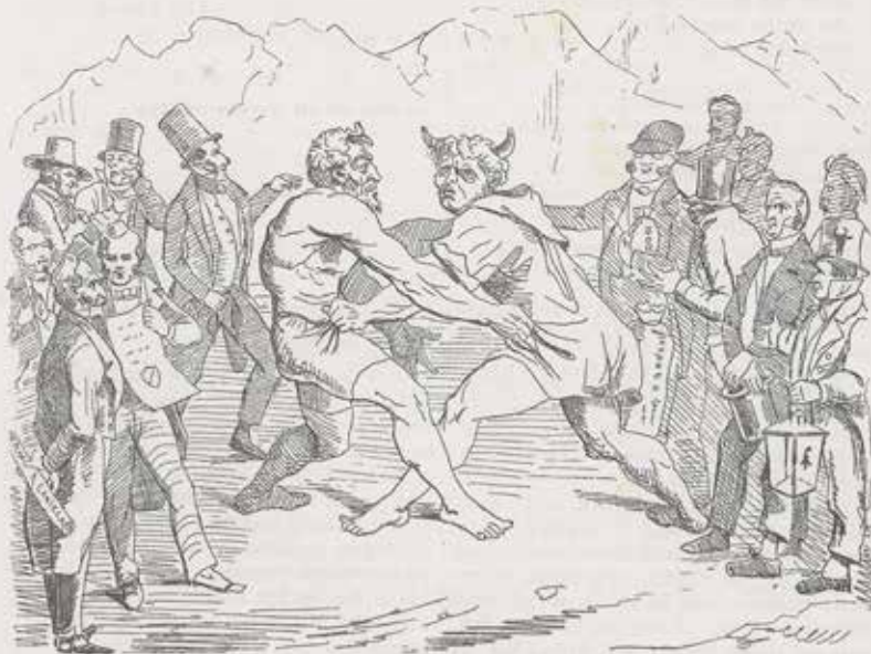
Der Hofenlupf des Gotthards und Lufmaniers.
