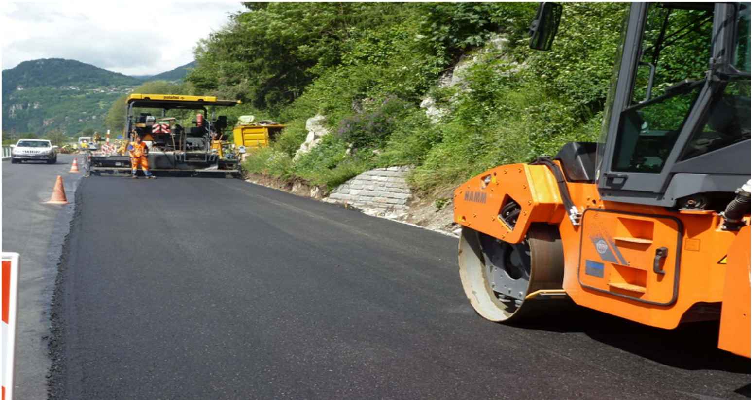
Einsatz von Recyclingasphalt AC 22 F Catram
