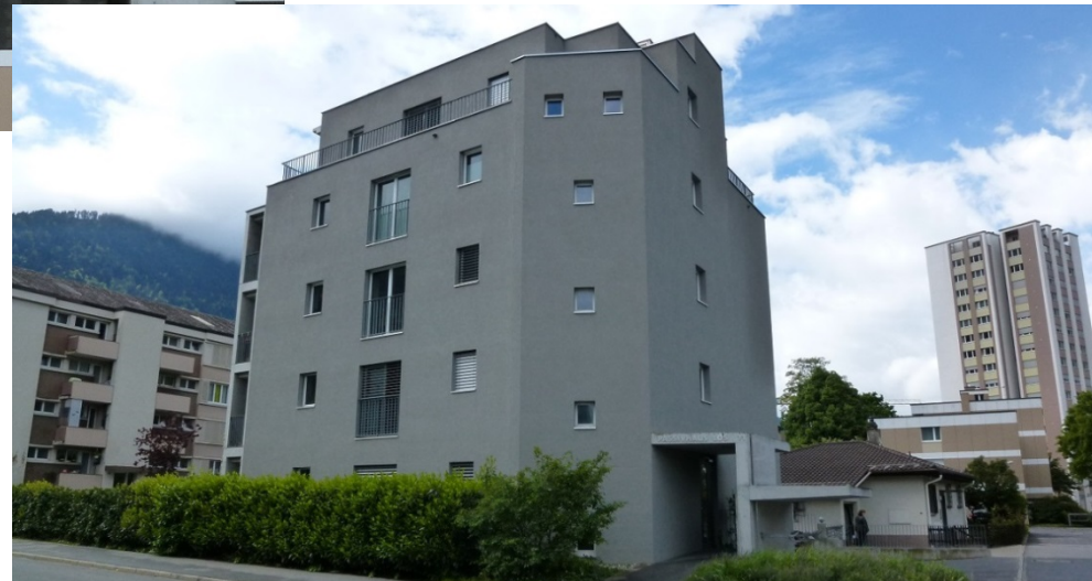
Einsatz von Sekundärbaustoffen
