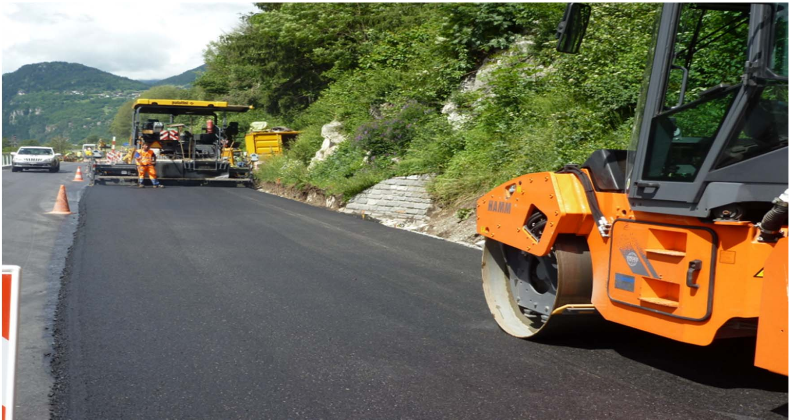
Uso di asfalto riciclato AC 22 F Catram
