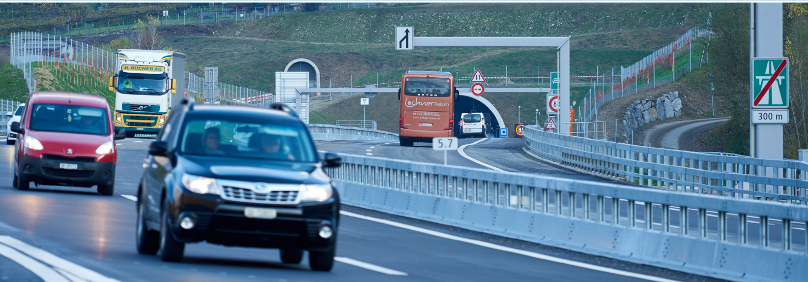
Umfahrung A13 Roveredo, Südportal
