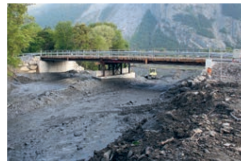
Rüfenniedergang Val Parghera in Domat/Ems mit Notbrücke über die Kantonsstrasse, 2013.
