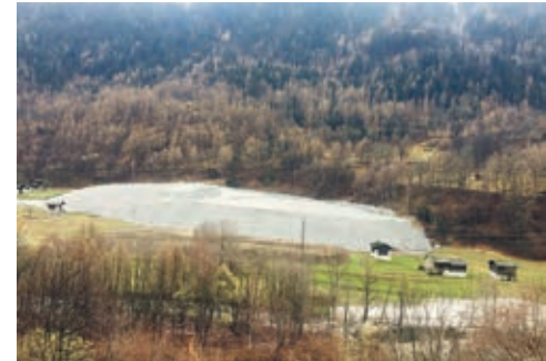
Deponierung von Material aus Naturereignissen (Bondo).
