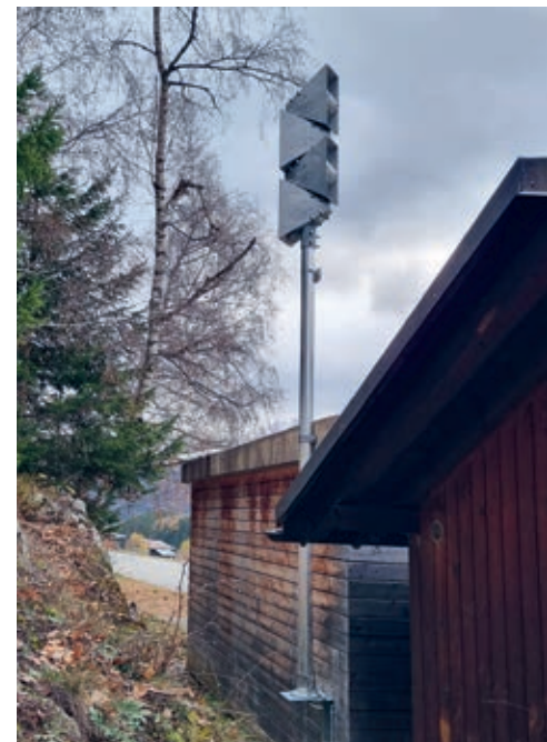
Stationäre Sirene zur Alarmierung der Bevölkerung.
